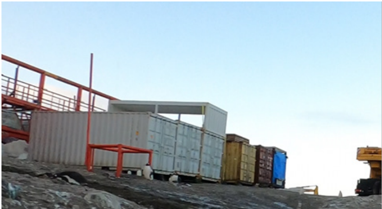
Figura 5. Lugar para instalación de la Antena
