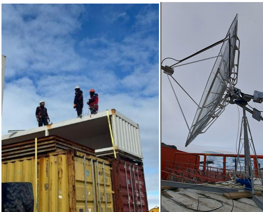
Figura 6. Lugar fijo establecido para la instalación de la antena
