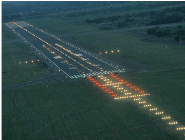
Figura 12. Sistema de luces de aproximación
