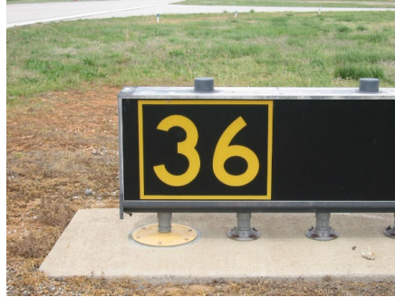
Figura 32. Letrero de emplazamiento en pista
