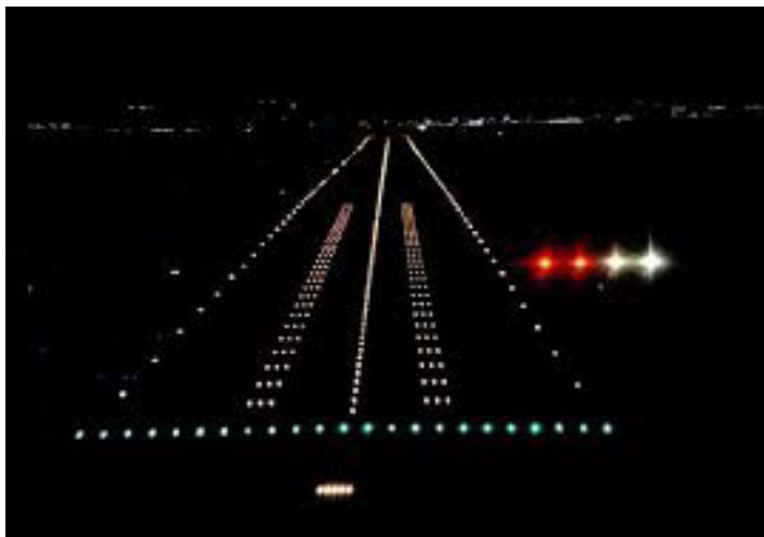
Figura 49. Ejemplo luces de toma de contacto
