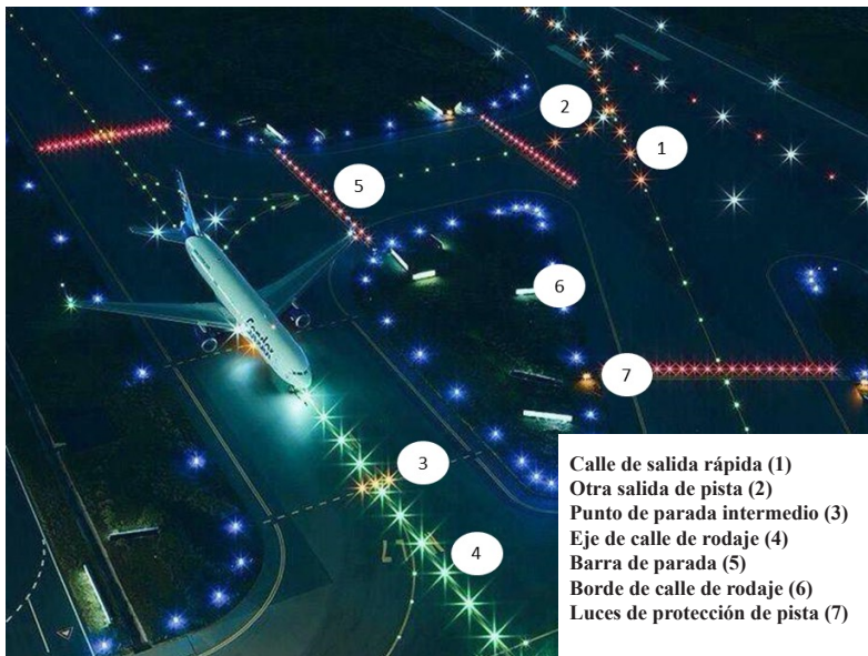
Figura 52. Luces de calle de rodaje
