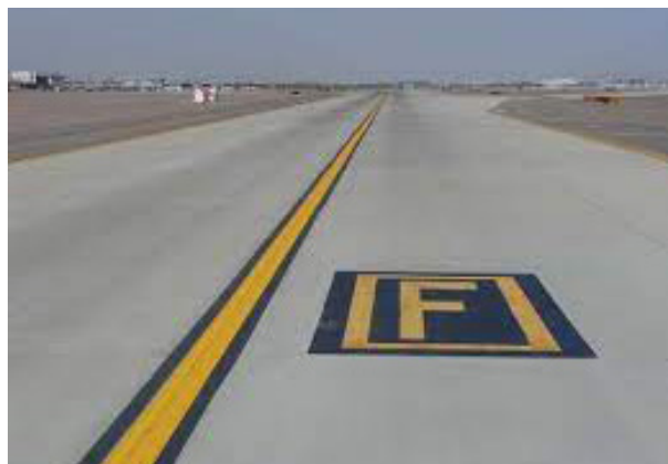
Figura 19. Señales de ubicación marcadas en la calle de rodaje
