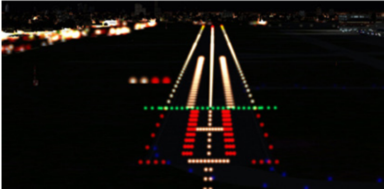
Figura 47. Luces bordes de pista
