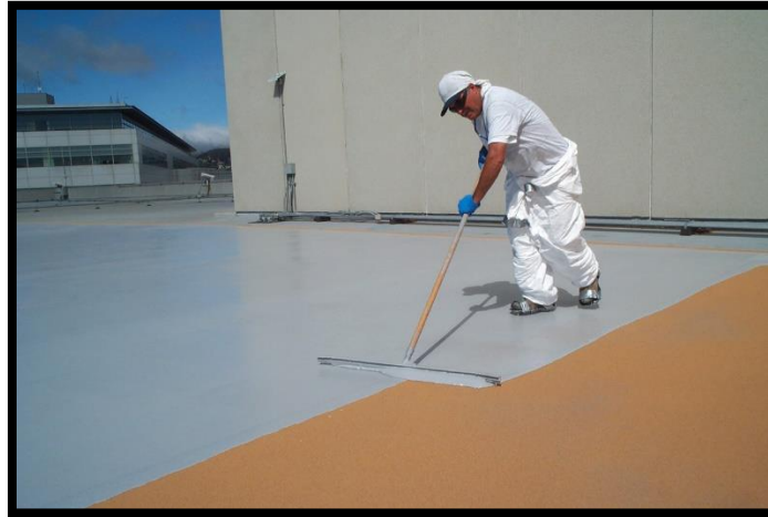
Figura 1. Obrero impermeabilizando la losa de un edificio
