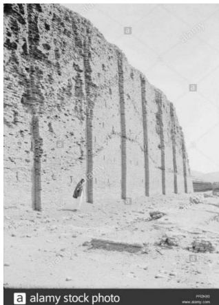
Imagen 6. Muro para la defensa de la ciudad de Ur.
