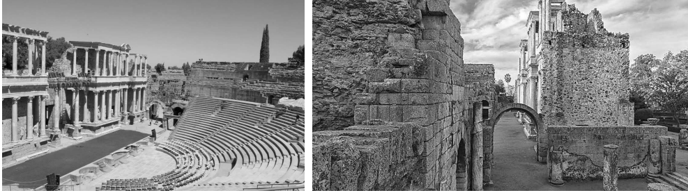
Figura 8. Opus caementicium en los muros del teatro romano de Mérida (Badajoz), construido hacia el año 16-15 a. C. y donado por el emperador Marco Agripa (yerno del emperador Augusto), data de casi la misma época de la fundación de Emerita Augusta. Tuvo algunas remodelaciones en siglo I y II d. C. Fuente imagen de la derecha: [54]. Fuente imagen de la izquierda: [54].
